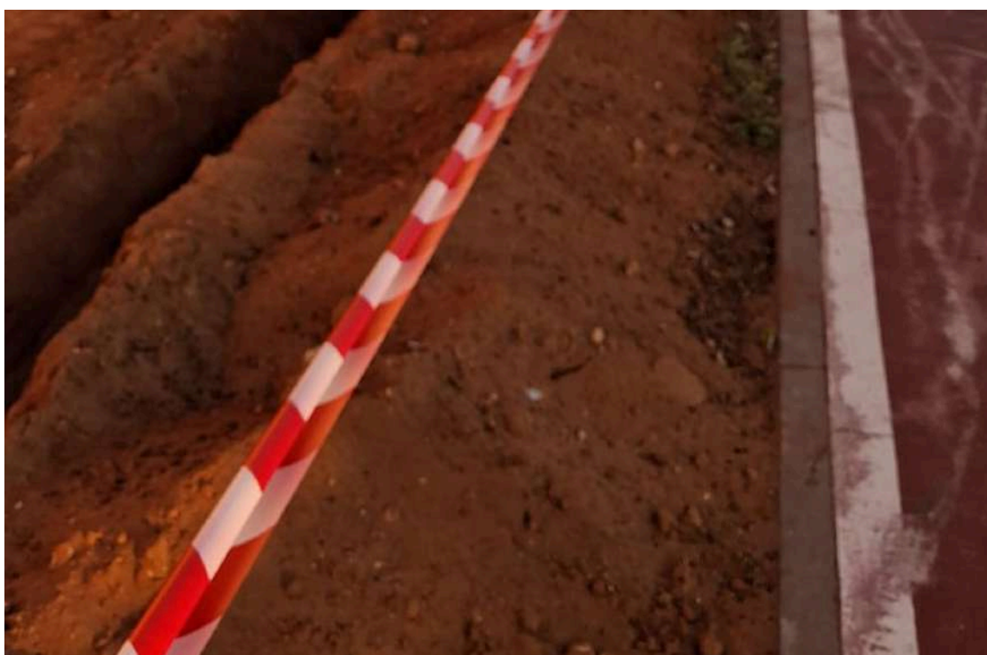
Una de las zanjas abiertas en el terreno.
