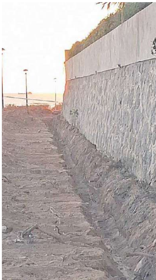
Una de las zanjas pegada al muro de una de las viviendas.
