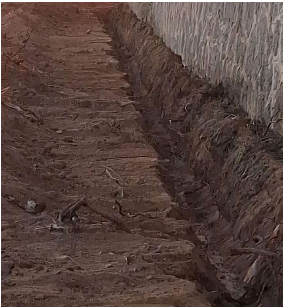
Una de las zanjas, pegadas al muro de una vivienda.
